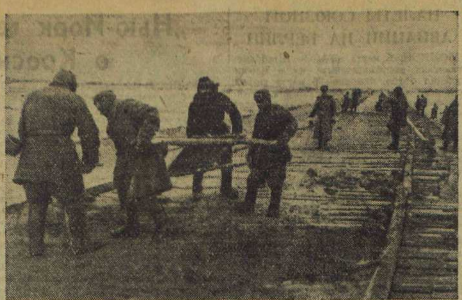
1-й БЕЛОРУССКИЙ ФРОНТ. Строительство гати через болото. Снимок нашего спец. фотокорр. О. Кнорринга.
