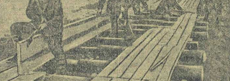
ДЕЙСТВУЮЩАЯ АРМИЯ. Ремонт фронтальной дороги. Снимок капитана П. Берштейна.
