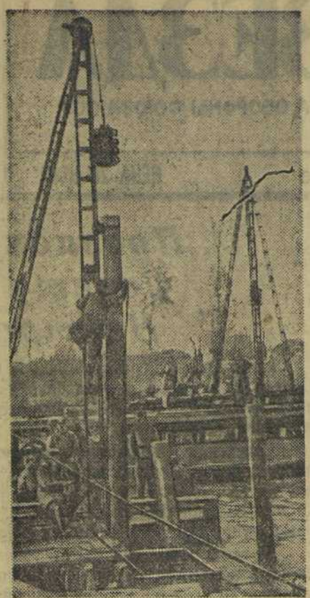
В ВЕНГРИИ. Бойцы Н-ской мостовой части сооружают переправу через реку.
